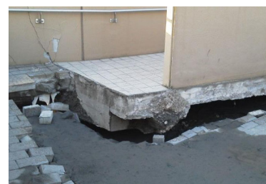
2011.3.11 東北地方太平洋沖地震による液状化の被害状況(千葉県浦安市内) 写真左)マンホールの浮き上がり 写真上)地盤(圧密)沈下
