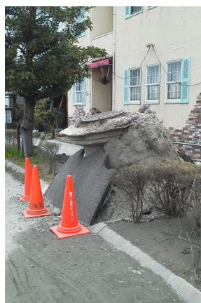
2011.3.11 東北地方太平洋沖地震による液状化の被害状況(千葉県浦安市内) 写真左)マンホールの浮き上がり 写真上)地盤(圧密)沈下
